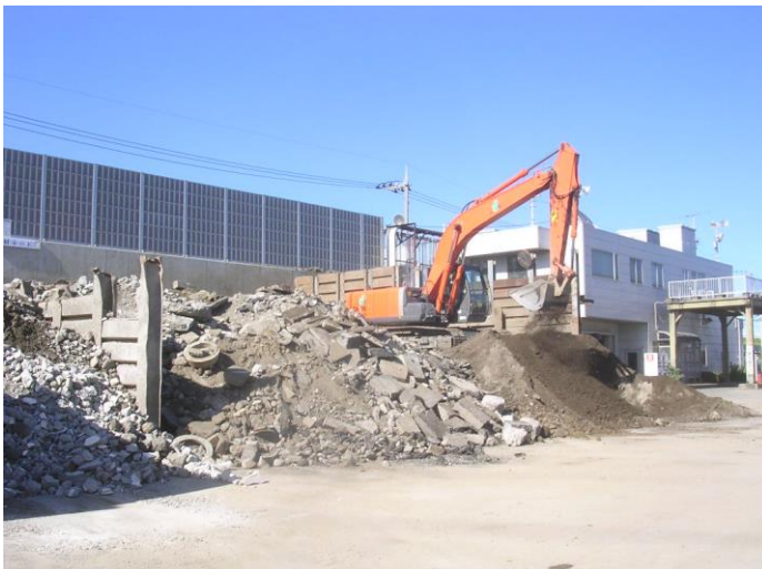
・残土ヤード全景
