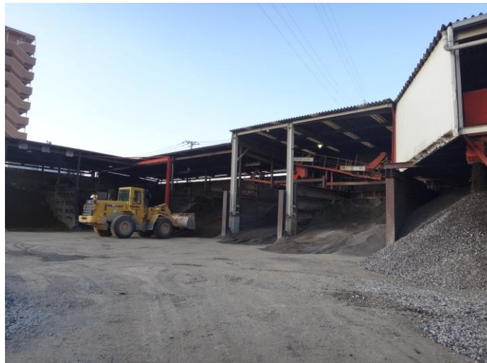
・製品ヤード全景
