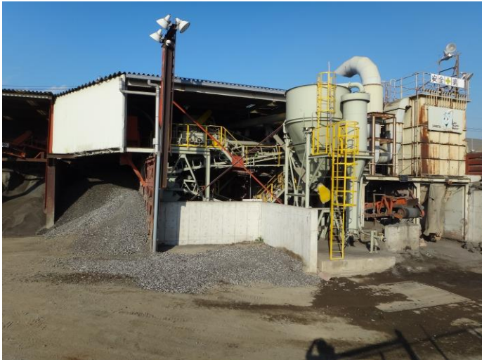
・リサイクルプラント全景
