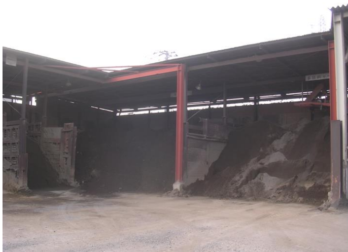
・改良土ヤード全景
