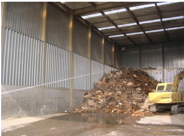
・廃材ヤード
