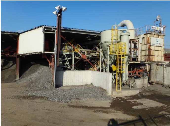
・リサイクルプラント全景
