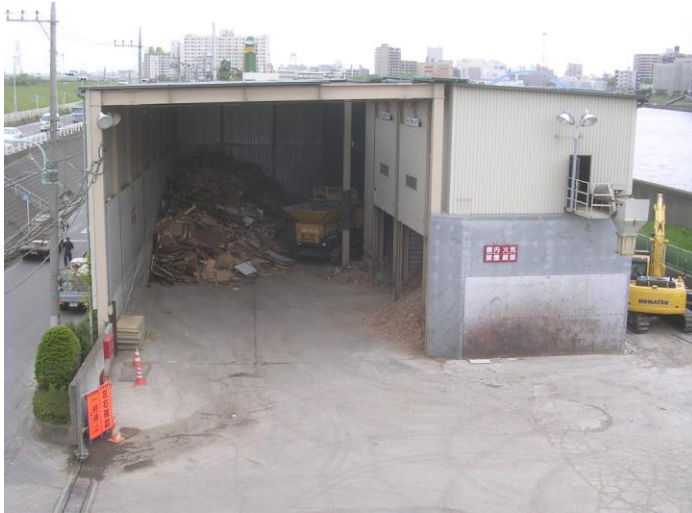
・木くず施設全景
