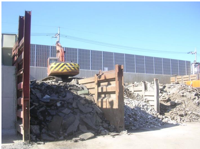
・廃棄物ヤード全景
