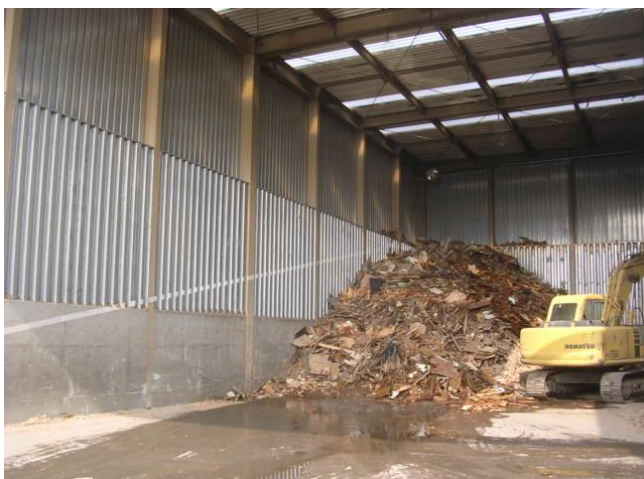
・廃材ヤード
