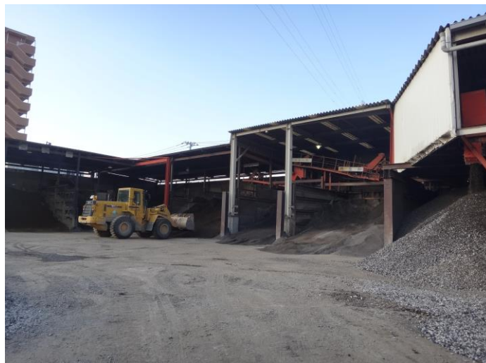
・製品ヤード全景
