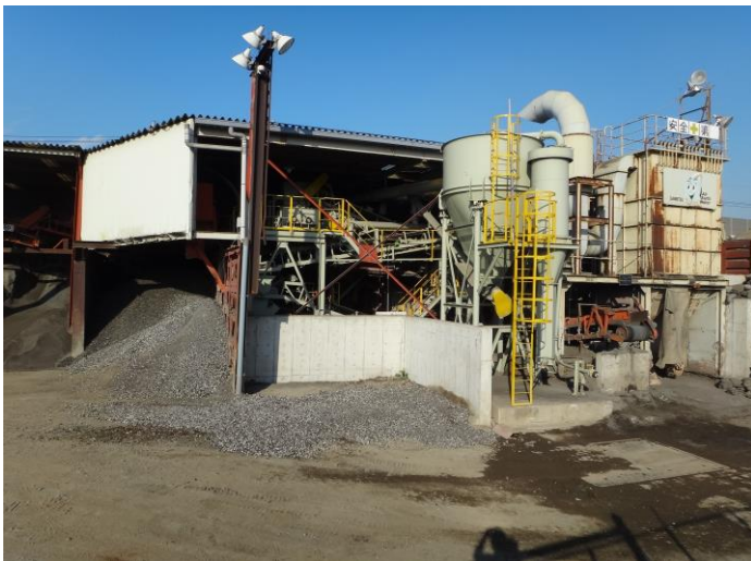
・リサイクルプラント全景
